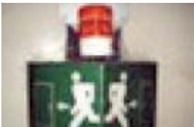
中央快速公路 (CTE) – 安装在门上的频闪灯。
