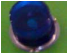
加冷 – 巴耶利峇快速公 (KPE)/滨海快速公路 (MCE) – 安装在逃生楼梯和隧道分隔门旁的频闪灯。
